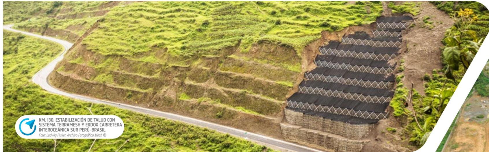
KM. 130. ESTABILIZACIÓN DE TALUD CON SISTEMA TERRAMESH Y ERDOX CARRETERA INTEROCEÁNICA SUR PERÚ-BRASIL
